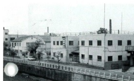
1962年当時の東方電機の社屋
